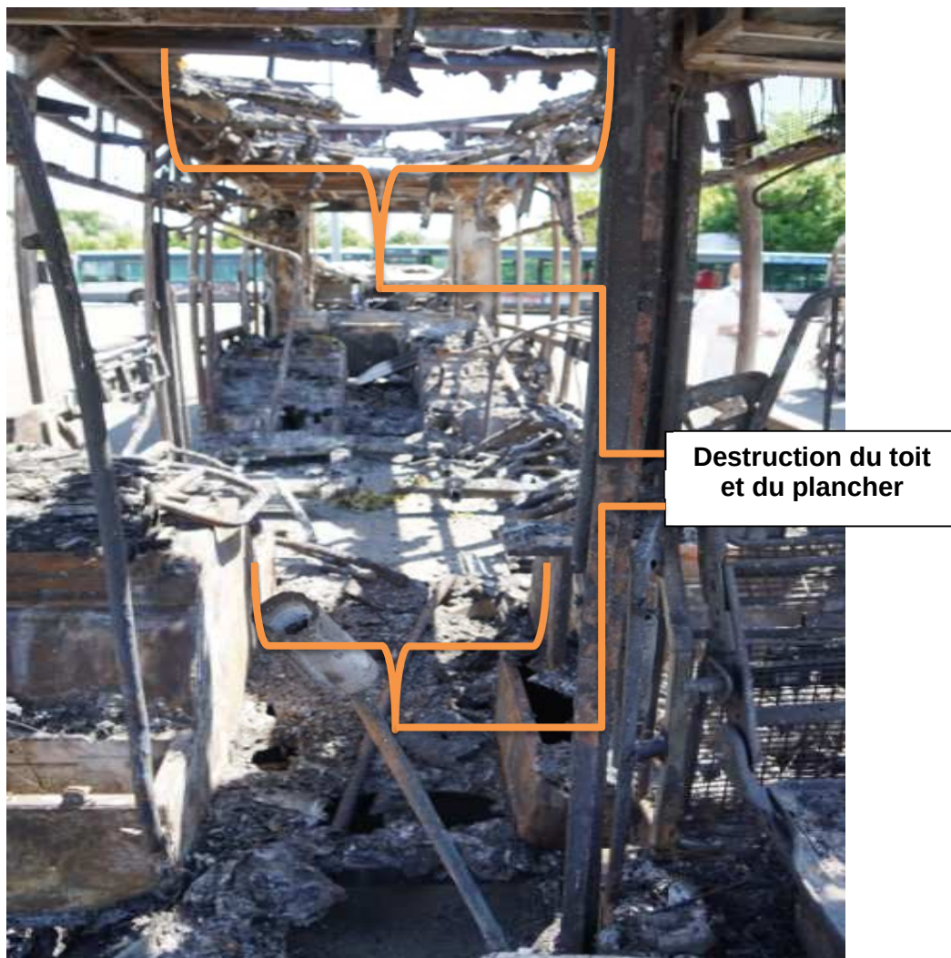
Figure 12 : Vue de l'intérieur Photo BEA-TT
